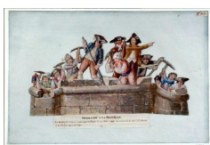
Demolición de la Bastilla
